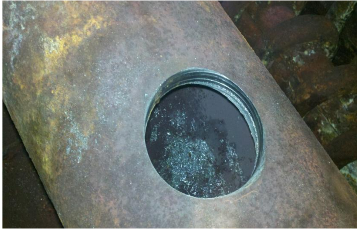
Access hole drilled into a HRSG header
