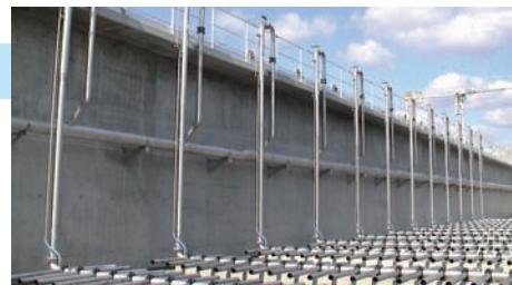
**Montage :** Le diffuseur AQUATUBE 90 s'adapte sur une nourrice circulaire en acier inoxydable DN 100 ou en PVC DN 110 par simple boulonnage.
